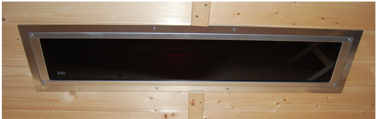
Saunafluter Deckeneinbau mit Aluminiumrahmen
