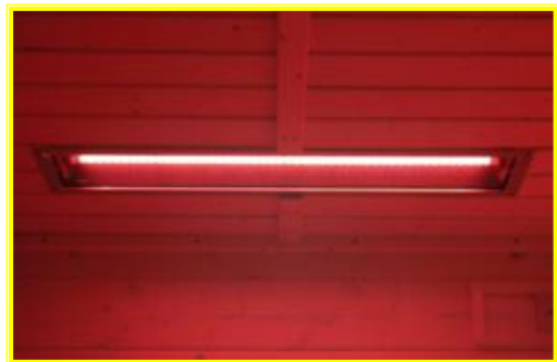
Eingeschalteter Deckenfluter 750 Watt
